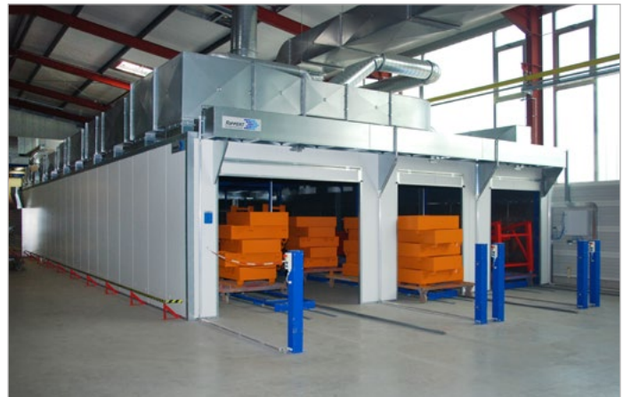
Halle de peinture avec tunnel de séchage
