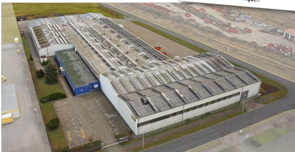
Usine 2 à Halberstadt
