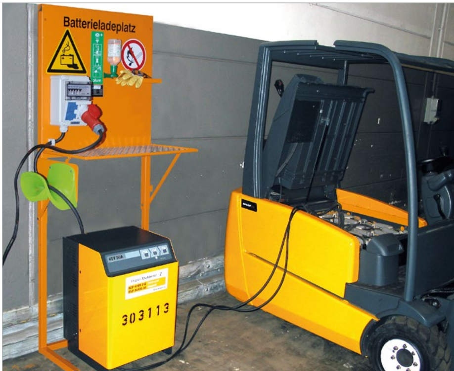
BL avec extincteur et prise de courant norme CEE 400 V et chariot élévateur en court de charge
